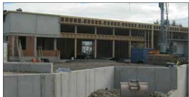
Stand der Arbeiten am 5.10.16. Foto: BAV Schärding
