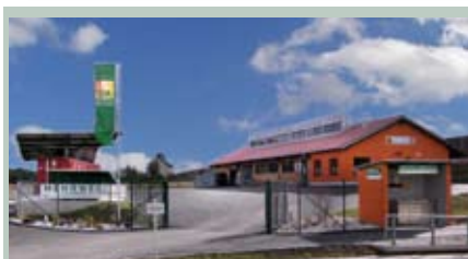
Insgesamt wurden in den letzten 20 Jahren 8 ASZ komplett neu gebaut. Damit steht der Bevölkerung eine moderne Nahentsorgung-Infrastruktur zur Verfügung.
