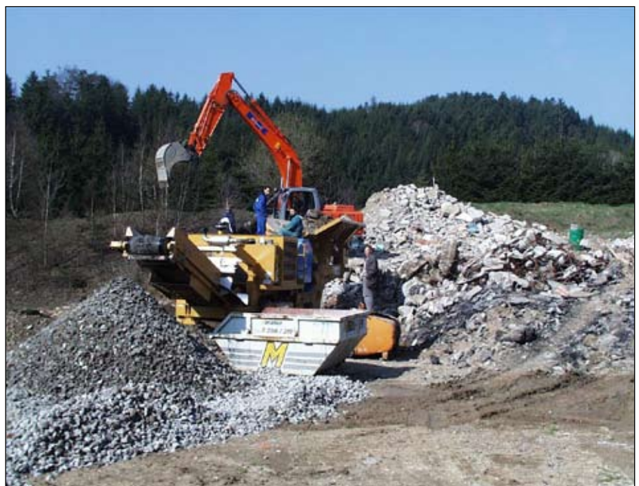
Mobile Bauschuttzubereitung nach positiver chemischer und physikalischer Analyse!
