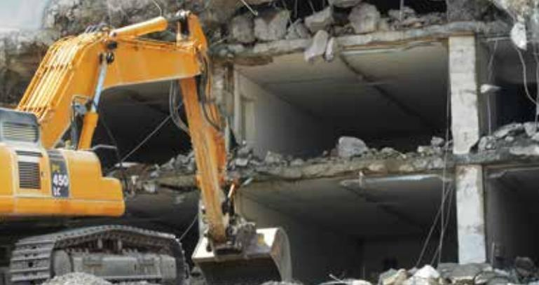
Ein Abbruch muss immer in umgekehrter Reihenfolge wie der Bau erfolgen! Das bedeutet, dass zuerst der Rohbauzustand hergestellt werden muss, bevor das Gebäude tatsächlich abgerissen werden darf! Foto: Markus Vogelbacher/pixelio.de
