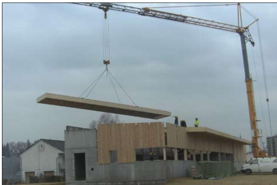
Montage der vorgefertigten Dachelemente durch die Firma Leithner, St. Florian. Foto: BAV Schärding
