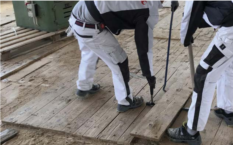
Abb. 1: Ausbau wiederverwendbarer Bodenbretter
